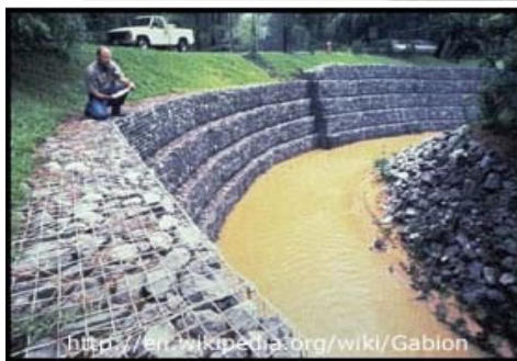
Gb. 12 Tembok Batu untuk Mencegah Erosi Air
