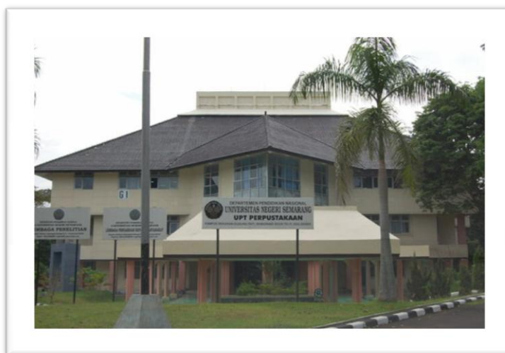
Gambar 2.11 Gedung G Unnes
