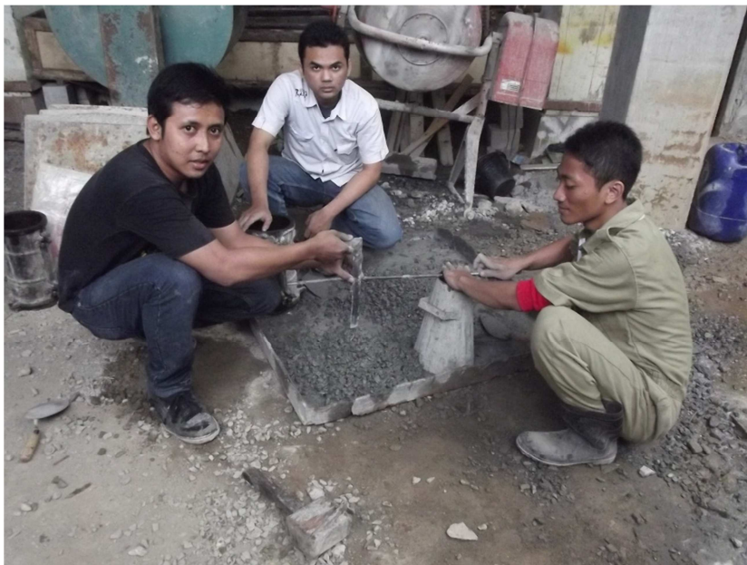
Gambar 4. Adukan beton dan pengujian slump
