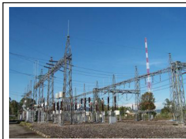
Gambar 2.11.. Rel Daya ( Busbar ).
