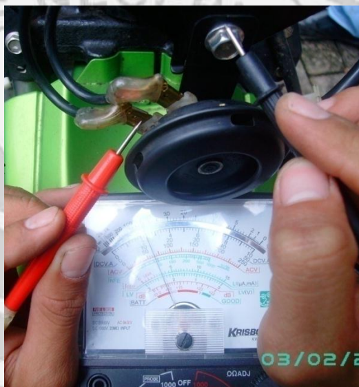
Gambar 3.32 Pengukuran tegangan pada terminal klakson
