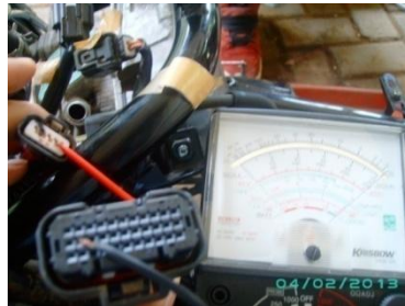
Gambar 3.17 Memeriksa hubungan kabel merah jambu/putih antara connector intake air pressure sensor dan connector ECU
