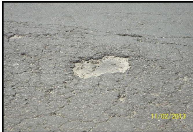
Gambar 2.8. Kerusakan Lubang
