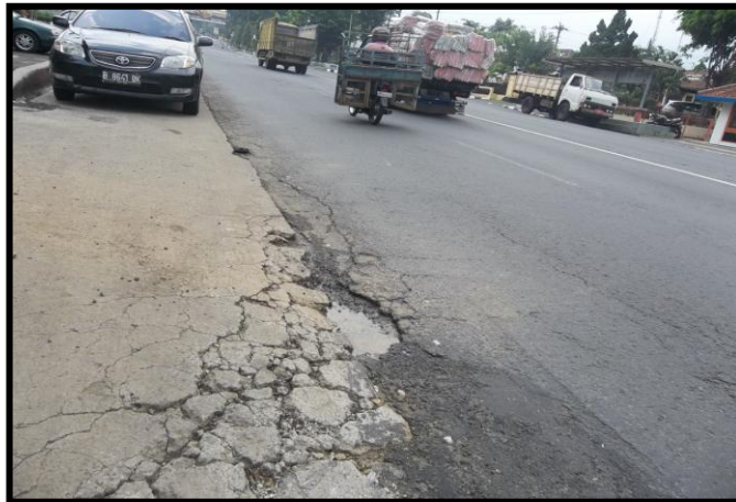
Gambar 2.6. Kerusakan Retak Pinggir
