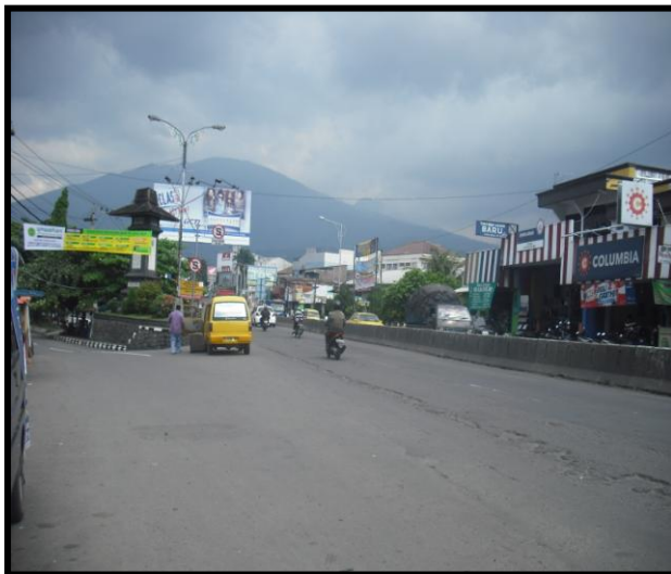
Gambar. Kerusakan Jalan
