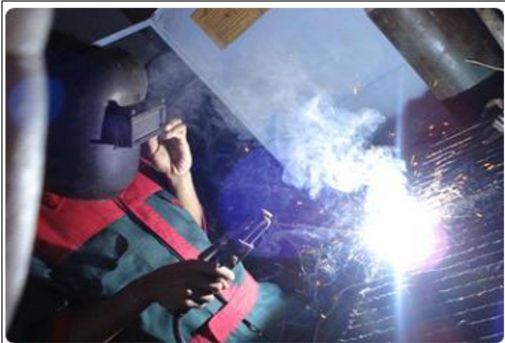
Pekerja las listrik yang menggunakan alat pelindung wajah
