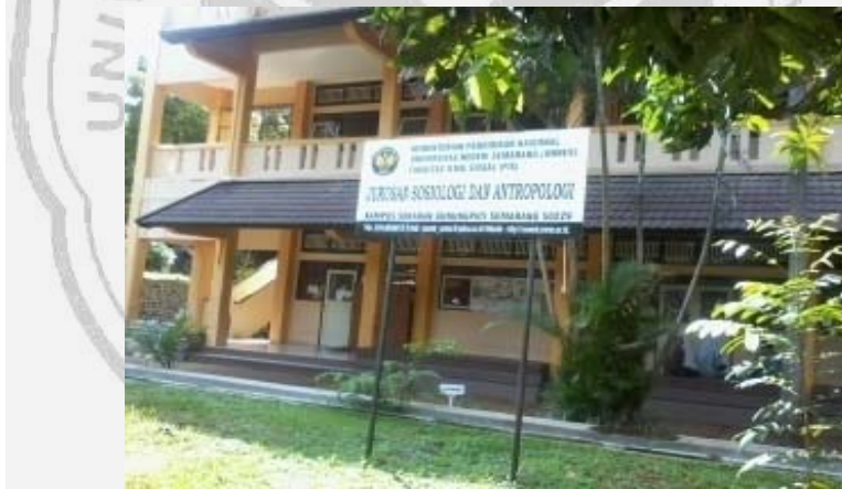
Gambar 1. Gedung perkuliahan Jurusan Sosiologi dan Antropologi tampak depan (Sumber: Dokumentasi Penelitian tanggal 6 Maret 2013)
