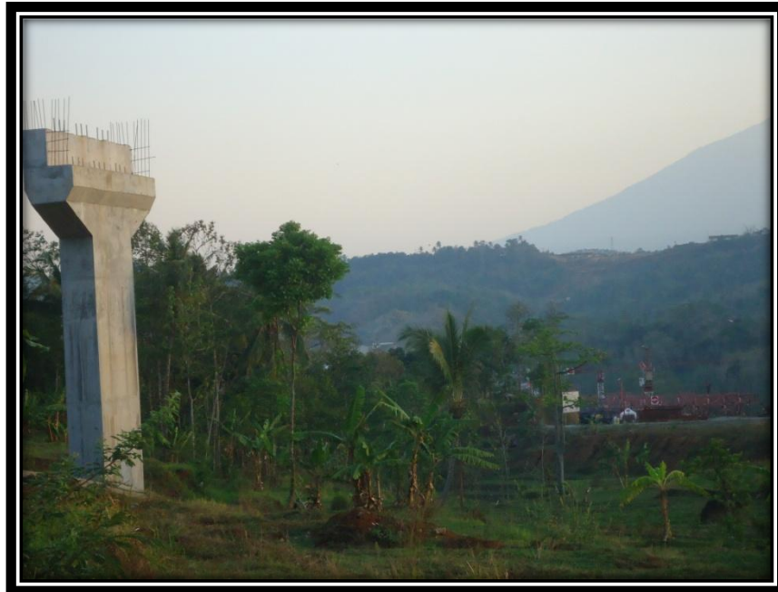
Foto 1 Foto tiang penyangga jalan utama
