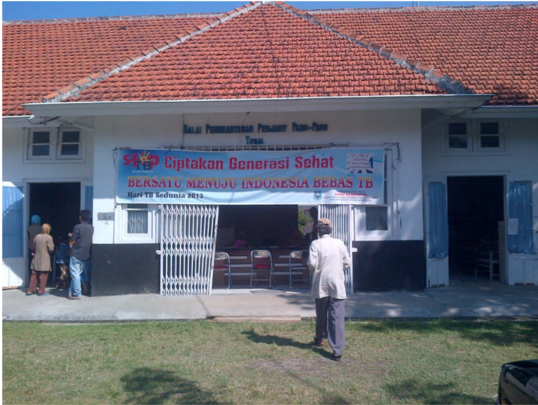
Balai Pengobatan Penyakit Paru-Paru (BP4) Tegal
