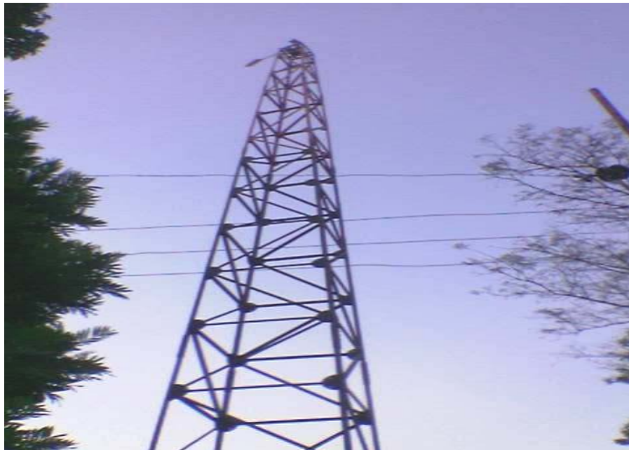
Gambar 14. Sebelum alternator dipasang
