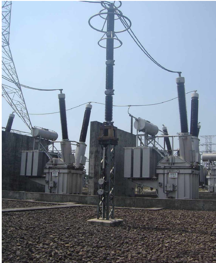
Gambar 2.7 : Gambar bentuk fisik arester type HLMN 136
