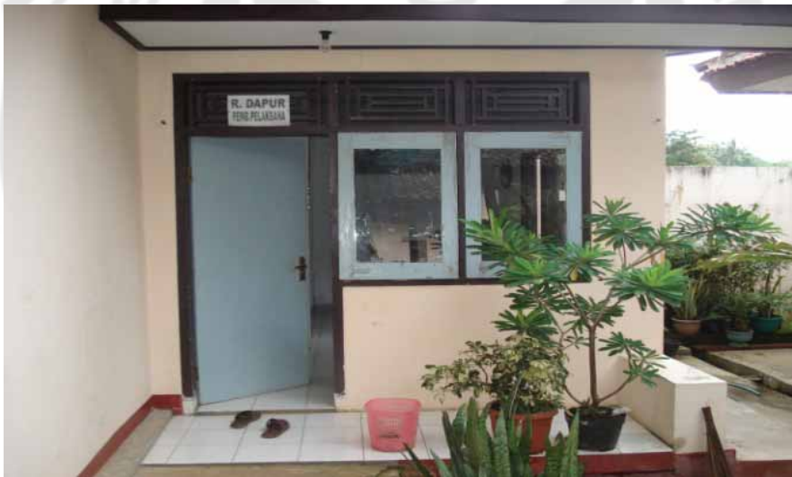
Gambar 17. Ruang Dapur terlihat dari luar
