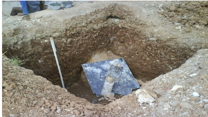
Pekerjaan Groundtank dan Septitank
