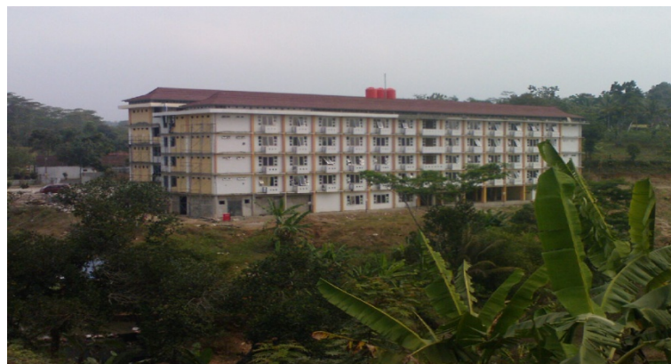
Pembangunan RUSUNAWA UNNES
