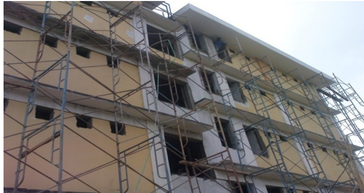
Pekerjaan Struktur Atas
