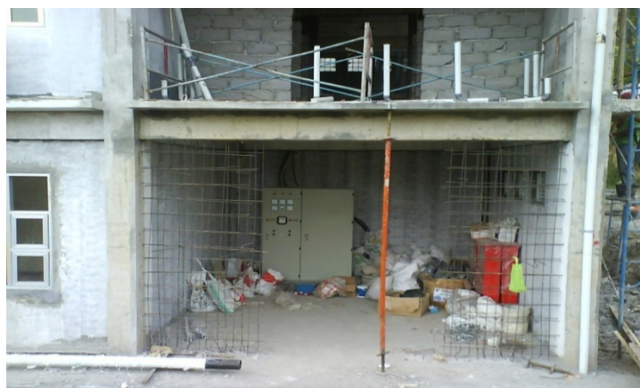
Pekerjaan Instalasi Elektrikal, Elektronik, dan Plambing
