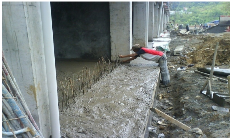
Pekerjaan Struktur Bawah
