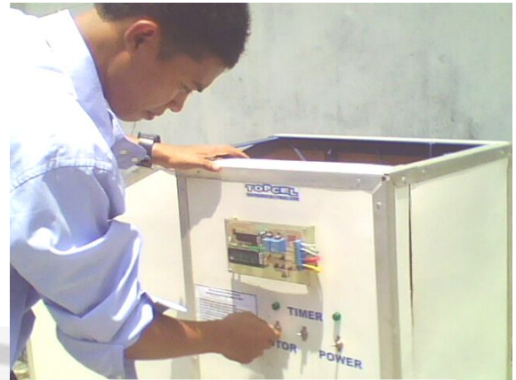
Menghidupkan Motor pada Control Panel
